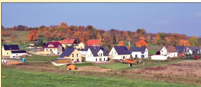
Baugebiet Am Ton
